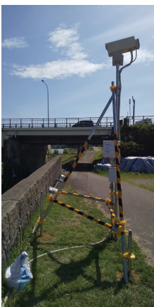
計測場所にカメラと通信機器を設置
